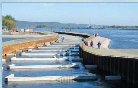
Der Fischpass am Elbewehr in Geesthacht besteht aus 49 einzelnen Becken, die jeweils 16 Meter breit, 9 Meter lang und rund 1,75 Meter tief sind. Die Schlitzlöcher sind an den Seiten jeweils 1,20 Meter breit. Die Anlage hat eine Gesamtlänge von 550 Metern.
