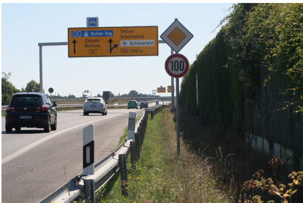
Die andere Seite der Lärmschutzwand
