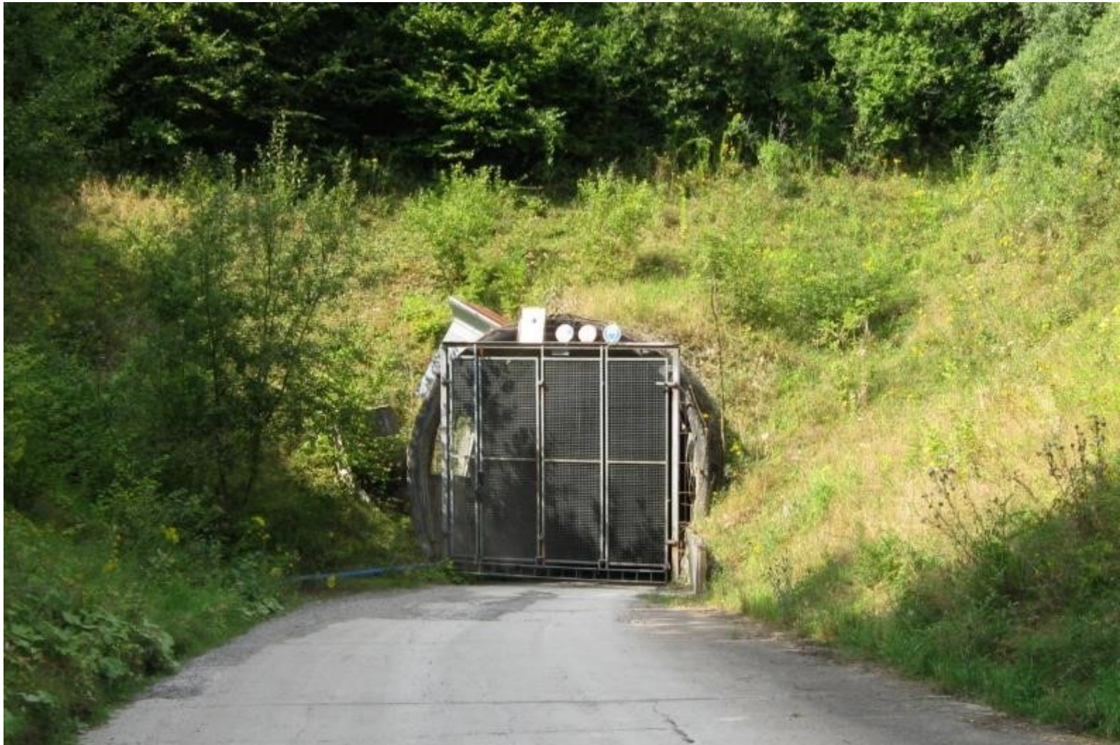
geringerer Eingriff: Gipsabbau untertage: Stolleneinfahrt im LK Holzminden
